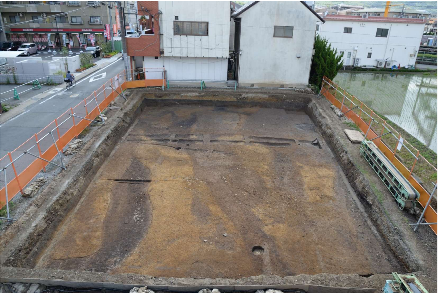
写真 3 右京第 1262 次調査第 1 調査区遺構検出状況（東から）
