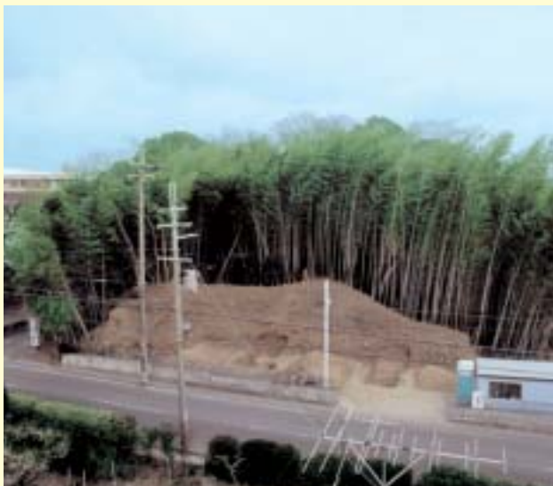
▲西側から見た土塁の様子(画面左奥が第九小学校)
